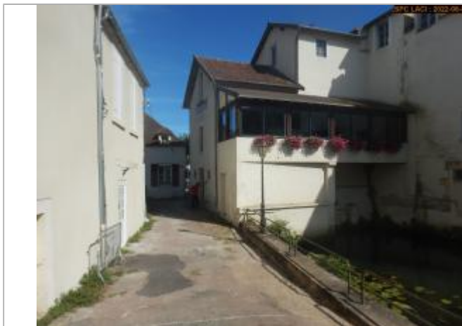
Vue du site éloignée
