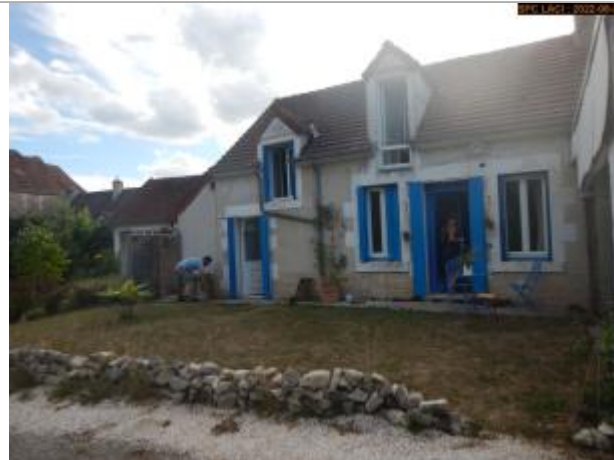
Vue du site éloignée
