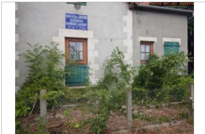
Vue générale du site
