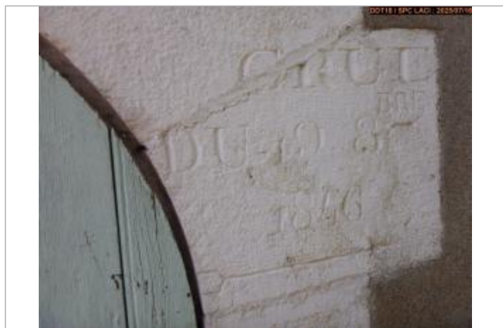
Vue du repère côté montant droit porte
