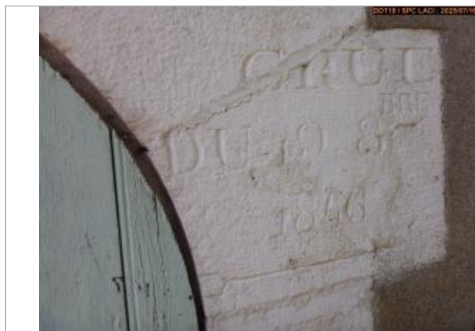
Vue du repère côté montant droit porte
