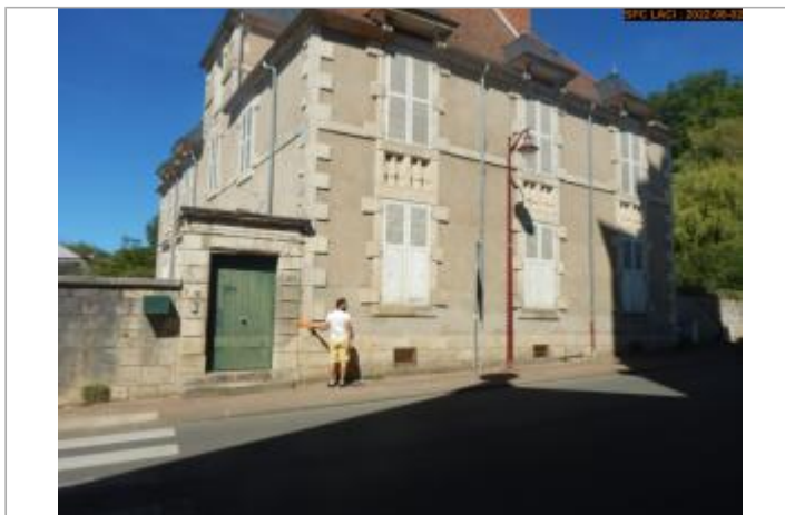
Vue du site éloignée
