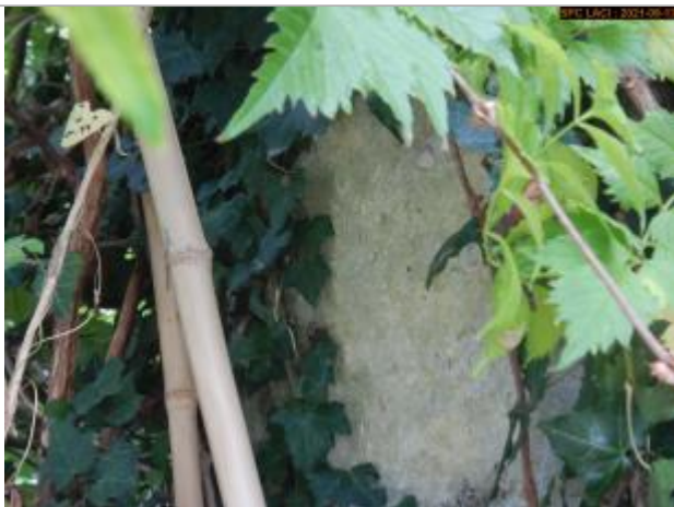
Vue du repère rapprochée en 2021
