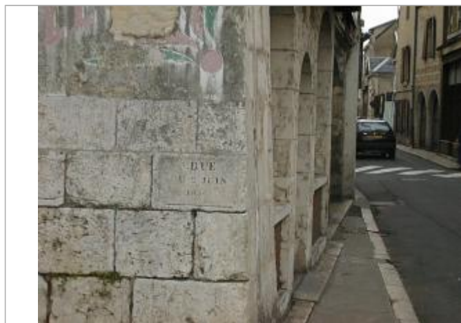
Vue du repère (recensement d'origine)
