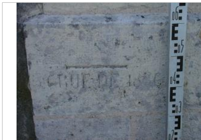
Vue détaillée du repère
