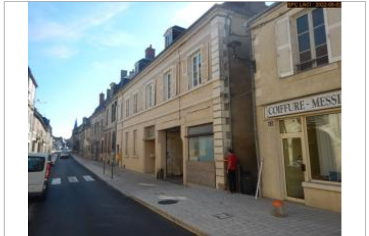
Vue du site éloignée
