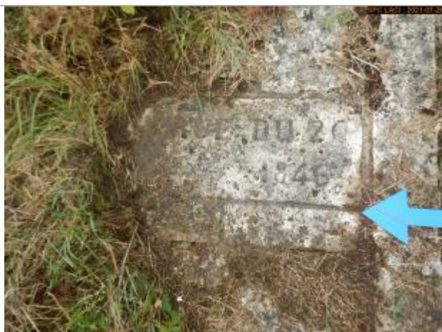
Vue du repère rapprochée en 2021
