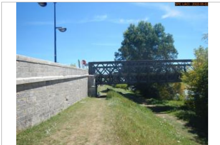
Vue du site éloignée
