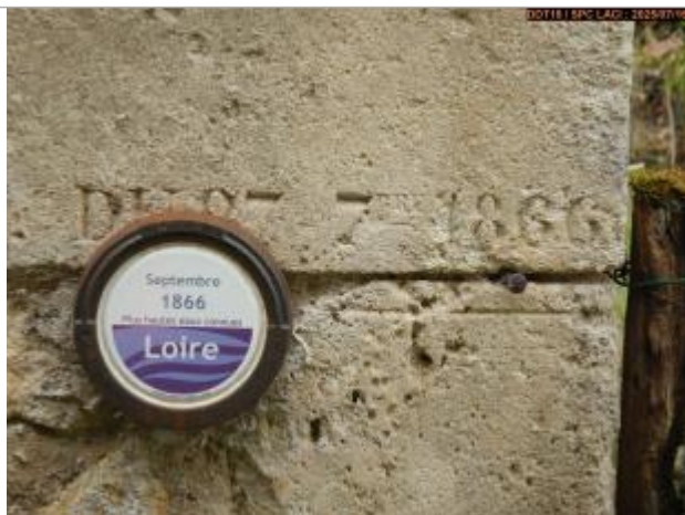
Vue du repère normalisé
