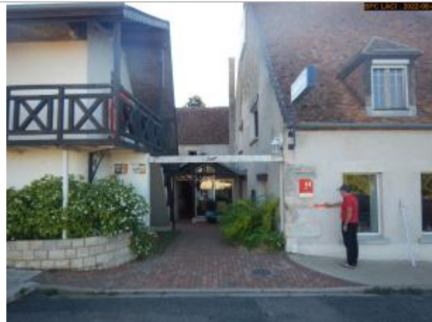
Vue du site éloignée
