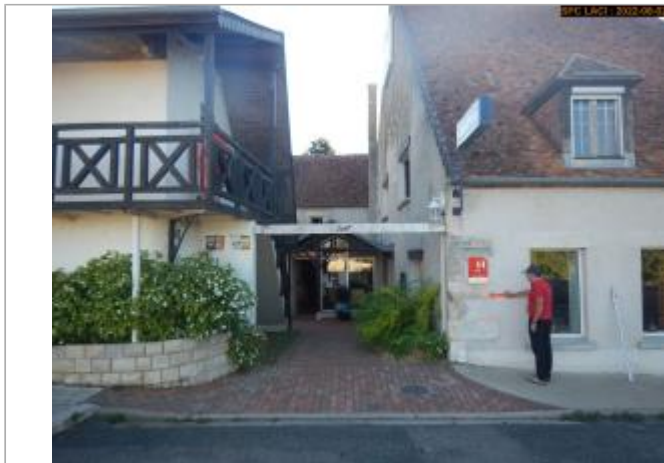
Vue du site éloignée
