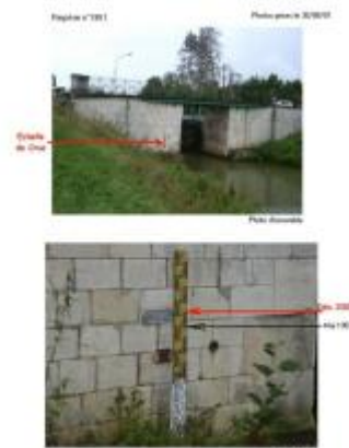
Photo Repères de crue (Site) - Auteur : Archive Navigation Nord Est
