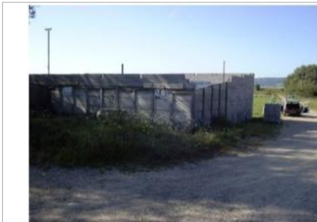
Photo Repères de crue (Site) - Auteur : Archive Navigation Nord Est
