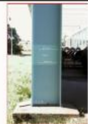
Photo Repères de crue (Site) - Auteur : Archive Navigation Nord Est
