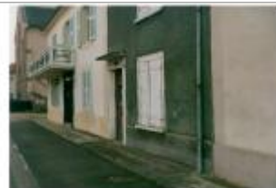
Gavisse , 20 rue de l'église Crue A83 - cote 151,36
