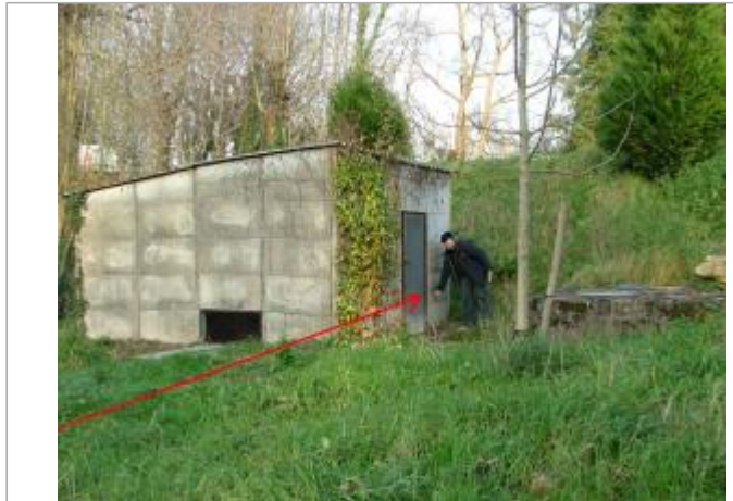
Photo Repères de crue (Site) - Auteur : Archive Navigation Nord Est
