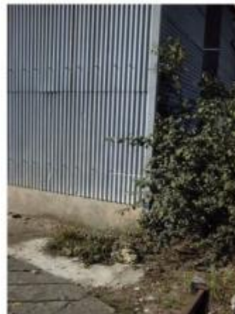
Photo Repères de crue (Site) - Auteur : Archive Navigation Nord Est
