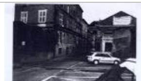
Photo n° 14-80-100 d'ensemble de la rue en allant vers l'église.
