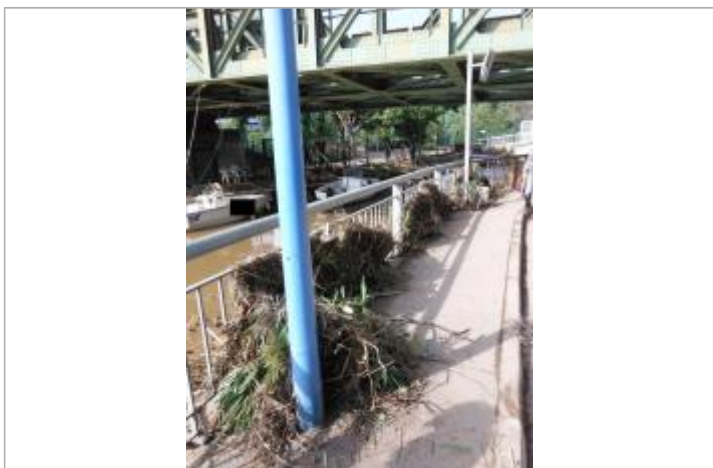
Photo PHE - Auteur : Société du Canal de Provence
