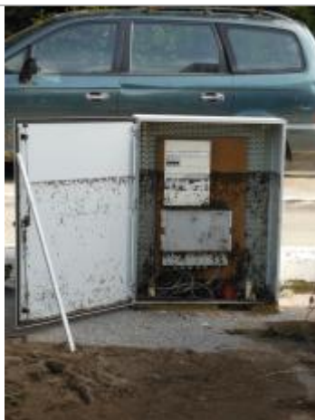
Photo PHE - Auteur : Société du Canal de Provence
