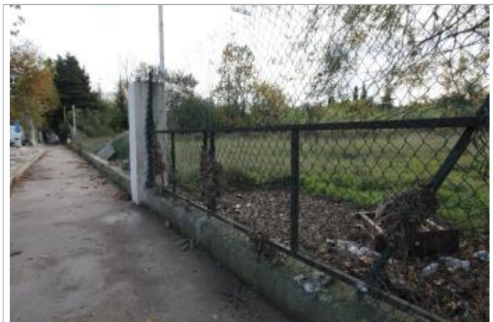
Photo PHE - Auteur : CEREMA Méditerranée
