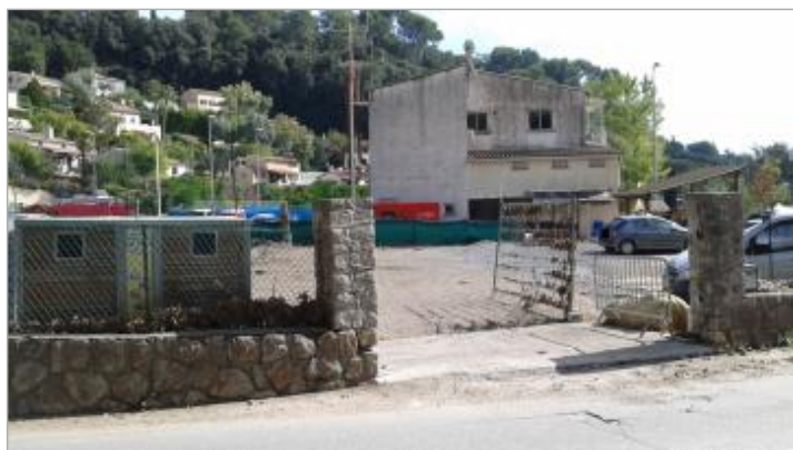
Photo PHE - Auteur : CEREMA Méditerranée
