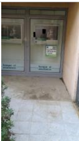
Photo PHE - Auteur : CEREMA Méditerranée
