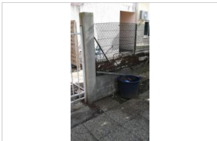
Photo PHE - Auteur : CEREMA Méditerranée
