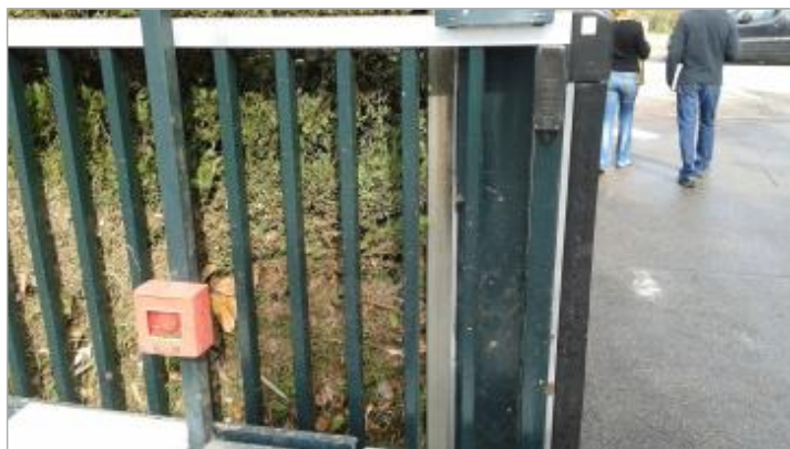
Photo PHE - Auteur : CEREMA Méditerranée
