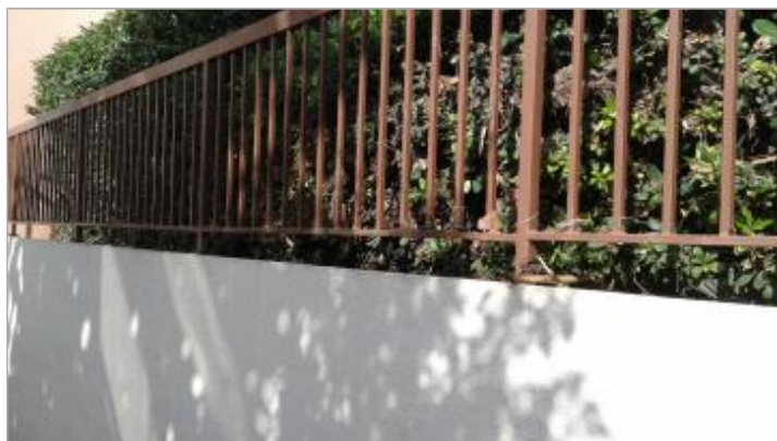
Photo PHE - Auteur : CEREMA Méditerranée
