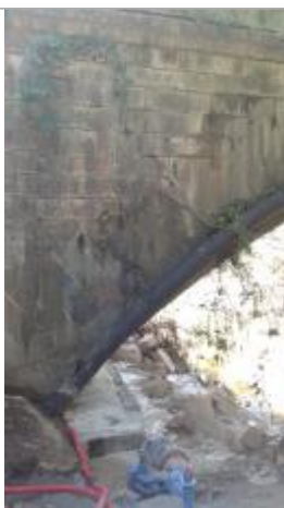
Photo PHE - Auteur : CEREMA Méditerranée
