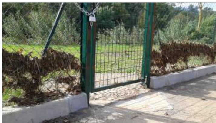
Photo PHE - Auteur : CEREMA Méditerranée
