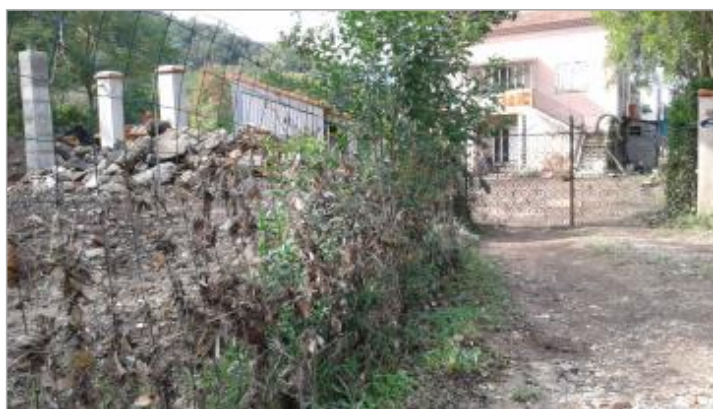
Photo PHE - Auteur : CEREMA Méditerranée
