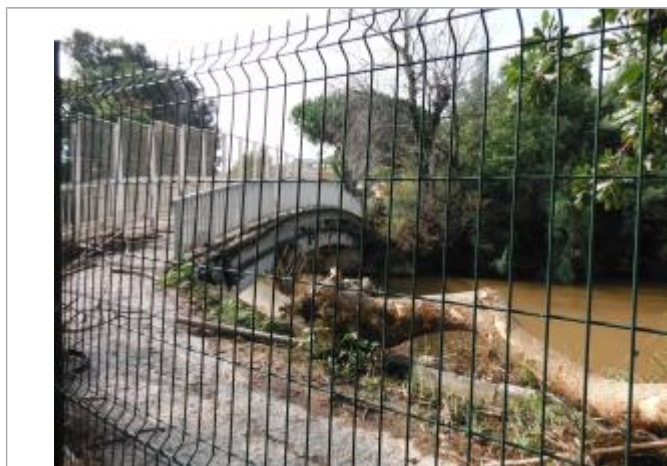
Photo PHE - Auteur : Société du Canal de Provence
