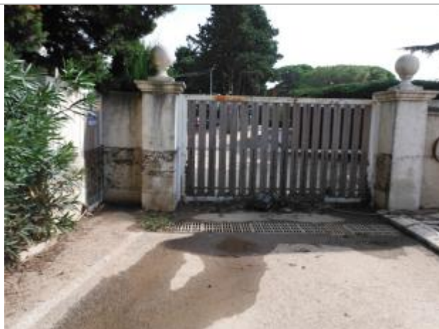
Photo PHE - Auteur : Société du Canal de Provence
