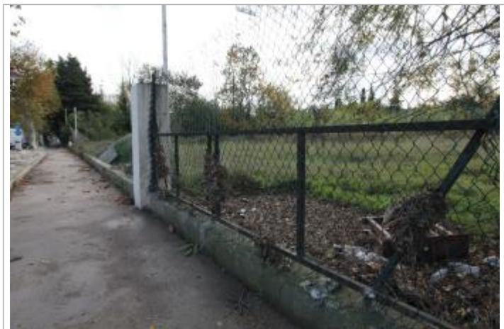
Photo PHE - Auteur : CEREMA Méditerranée
