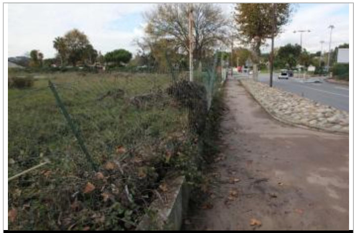
Photo PHE - Auteur : CEREMA Méditerranée
