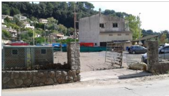
Photo PHE - Auteur : CEREMA Méditerranée
