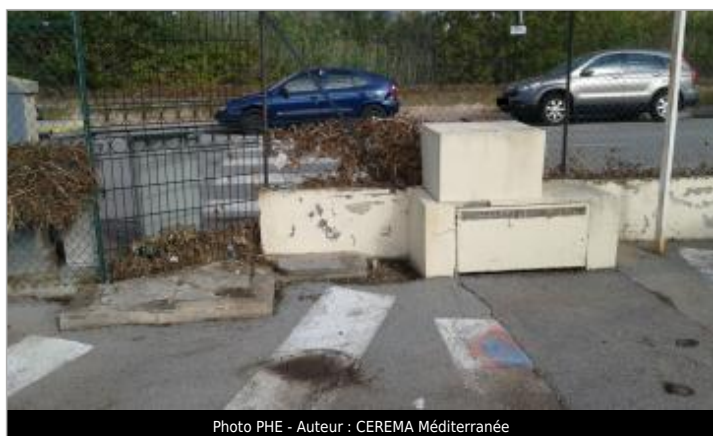
Photo PHE - Auteur : CEREMA Méditerranée
