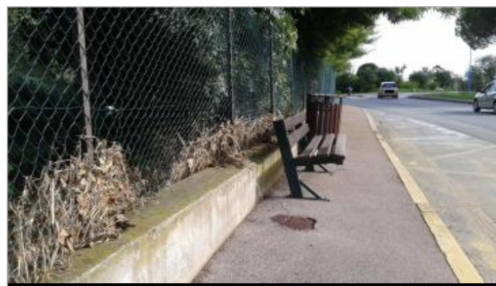
Photo PHE - Auteur : CEREMA Méditerranée
