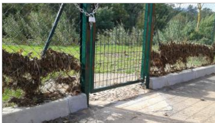
Photo PHE - Auteur : CEREMA Méditerranée
