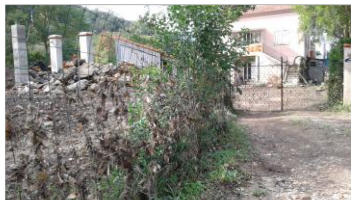
Photo PHE - Auteur : CEREMA Méditerranée
