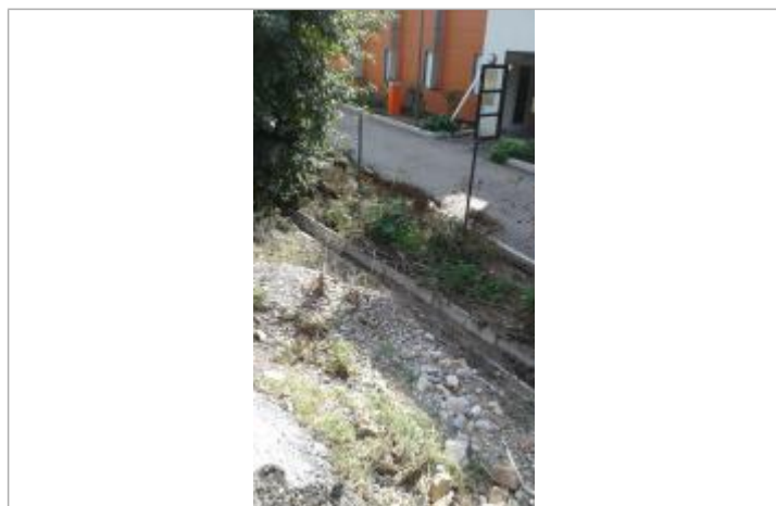
Photo PHE - Auteur : CEREMA Méditerranée
