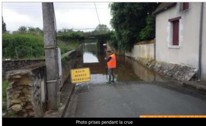
Photo prises pendant la crue
