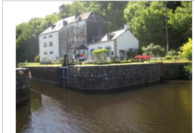
aval écluse du Roch à Saint-Thuriau (échelle disparue)
