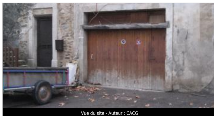
Vue du site - Auteur : CACG
