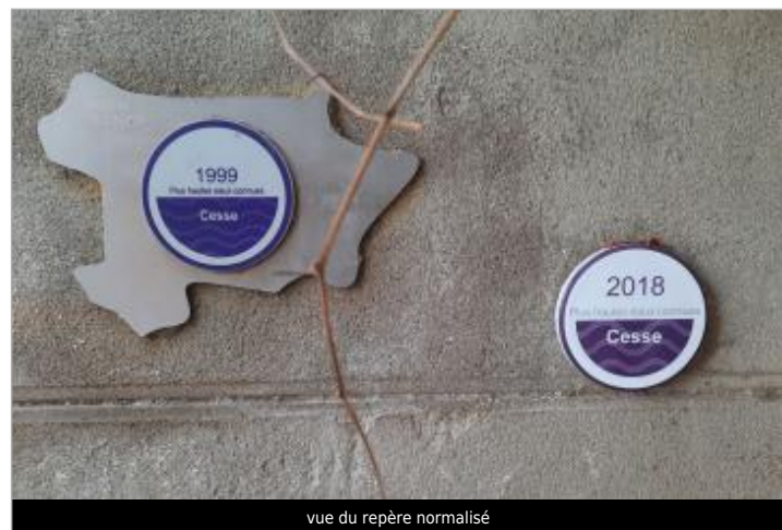
vue du repère normalisé
