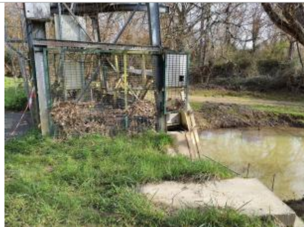
Vue du site, mars 2026, prise de vue SPC GTL.
