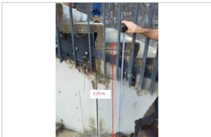
Vue du repère, mars 2026, prise de vue SPC GTL.
