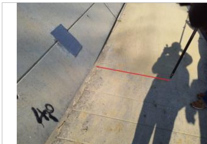
Vue du repère, mars 2026, prise de vue SPC GTL.
