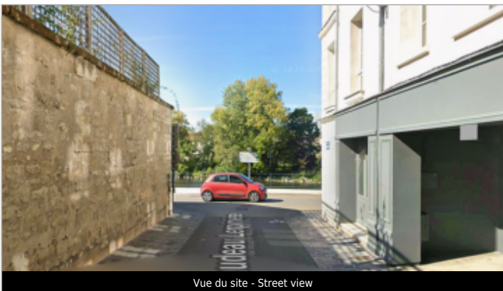
Vue du site - Street view
