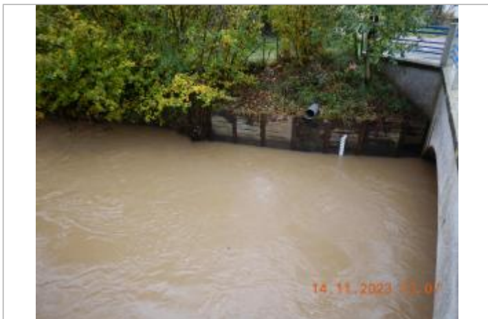
Debordement de cours d'eau
